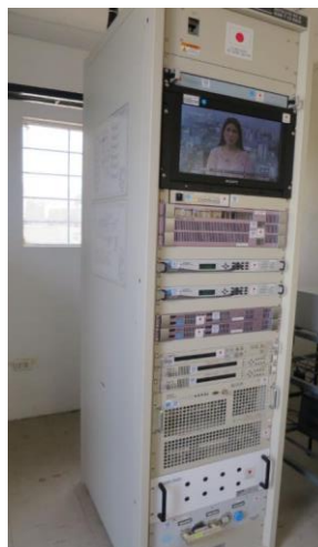
Sistema de transmisión (100W)
