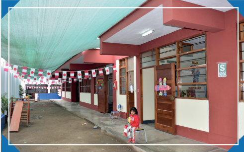
Proyecto de Reconstrucción de la Institución Educativa Inicial "Las Palmas de la Sierva de Dios Melchora"- Distrito de Grocio Prado - Provincia de Chincha - Departamento de Ica
